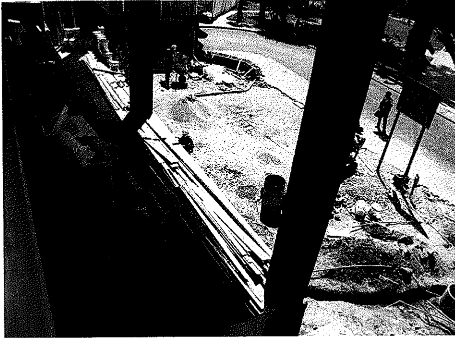
Fotografía 1: Ejecución Partida "Estacionamiento"
